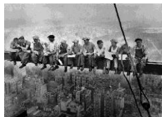
Fotografia de: Charles C. Ebbets Operários a almoçar nas alturas durante a construção do edifício RCA no Rockefeller Center (EUA, 1932)
